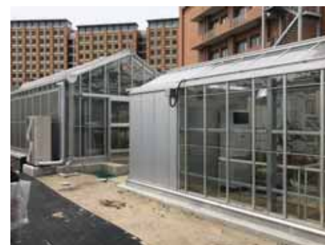
組換え植物に対応した閉鎖温室(手前)と、主に冬期の栽培に利用する温室(奥)。
